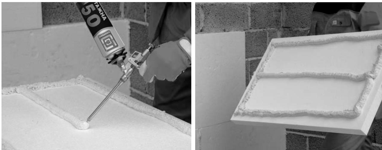
Рисунок 2. Способы нанесения клея на поверхность плит утеплителя.
